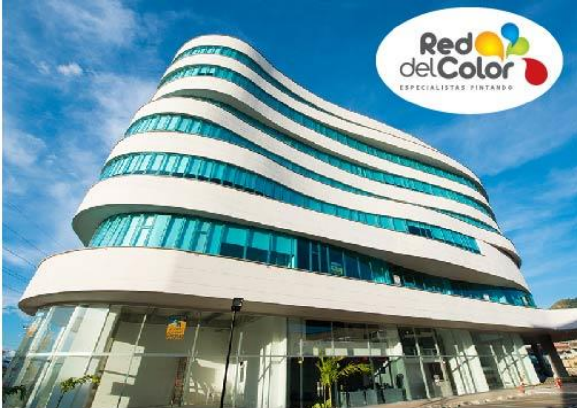
OBRA: SABANA FACHADA SABANETA
